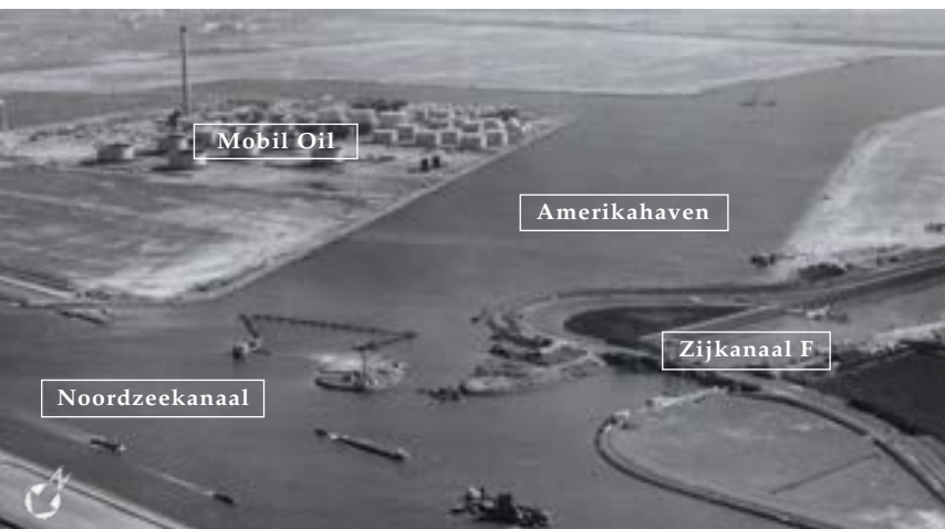
Mobil Oil, een nog eenzame olieraffinaderij temidden van oneindige kale spuitvelden aan de ingang van de nog onvoltooide Amerikahaven. Rechts de monding van zijkanaal F. jaren zeventig
