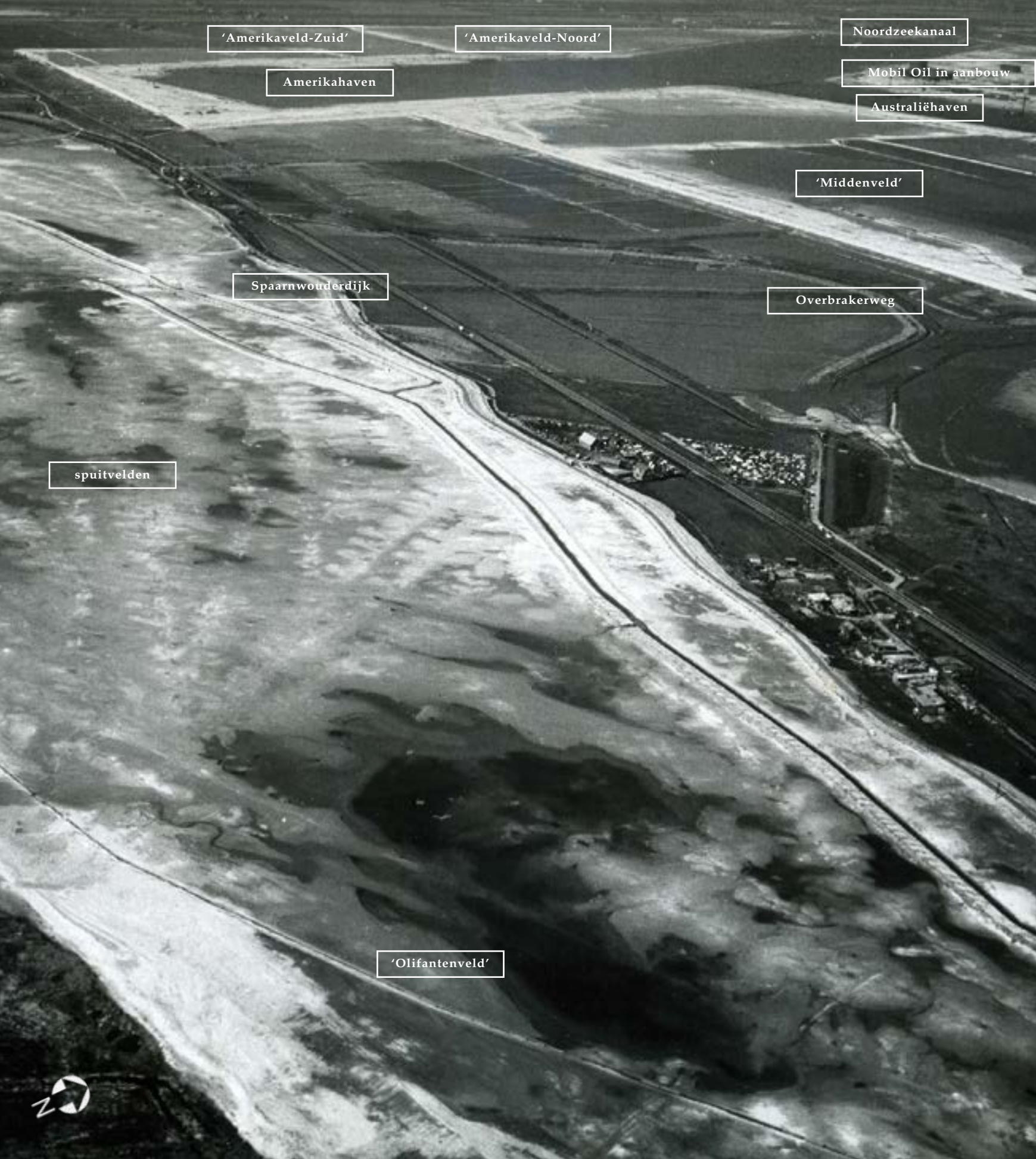
Opspuitingen in het Westelijk Havengebied, gezien in noordwestelijke richting. Uiterst rechtsboven Mobil Oil, in aanbouw, aan Amerika- en Australiëhaven. Aansluitend het rechthoekige 'Middenveld'. Het witte gedeelte in het midden zijn de uitgebreide spuitvelden richting de spoorlijn Amsterdam-Haarlem. 1967
