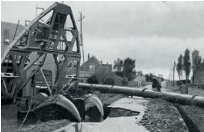
Bij het uitzuigen van de Sloterdijkermeerpolder tot Sloterplas ging men niet altijd subtiel te werk. Hier wordt dwars door de Uitweg (ten westen van de polder) gegraven. 1949
